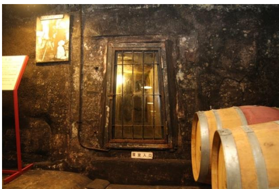
岩の原葡萄園のワイン貯蔵庫は温度変化の少ない地下の石室。写真のドアは、醸造タンクを冷却するために使った雪室への出入口
