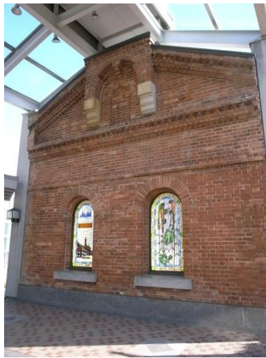
アサヒビール吹田工場に保存される、1899年の創業当時の工場の壁
