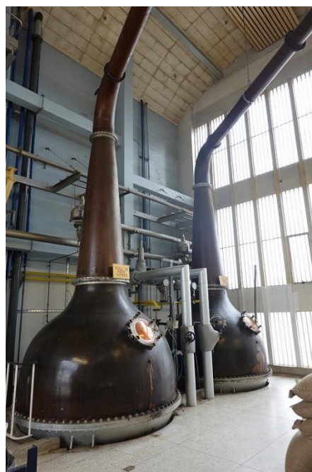
存在感のあるビーフィーターの蒸溜釜（ポットスチル）
